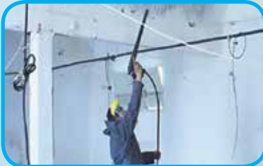
نزع الأوساخ من السقف بماء مضخة ذو ضغط مرتفع
