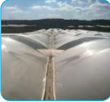
صور توضح تركيب البلاستيك علي البيت المحمي ذو الطراز المزدوج والمتعدد
