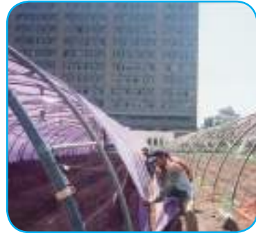
صورة توضح كيفية التركيب الغطاء البلاستيكي للبيت المحمي
