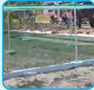
٦- تغطية سطح وجوانب الهيكل المعدني بالسيران
