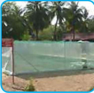
٦- تغطية سطح وجوانب الهيكل المعدني بالسيران
